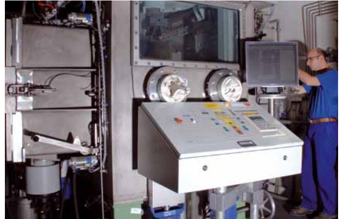
HTE Beschichtungskammer / HTE plating chamber
